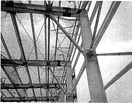
ひさしに適用された「J-UPブレース」④と「ニーブレース工法」
