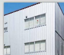
表面部の凹凸が美しい、デザイン性の高い壁パネル。表面材にコストパフォーマンスに優れたガルファン鋼板を使用。
