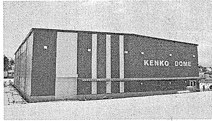
建設を支援した屋 内運動場
