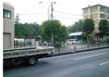
既設水道管が幹線道路下にあったため、歩道に設置したボーリング孔を用いて調査を行いました。騒音の影響を受けにくいため、交通規制などを行うことなく日中に作業を行うことができました。
