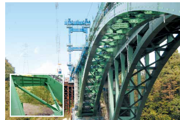
新潟県 太田切川橋(上信越自動車道)
