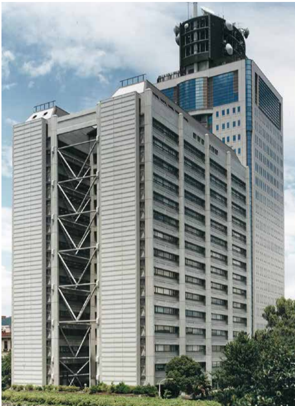
静岡県庁東館
