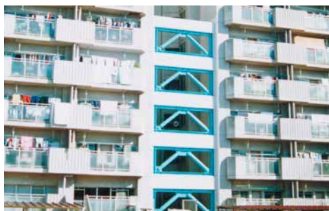
兵庫県 A高層団地
