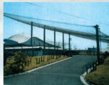
ゴルフ練習場に近接した管理通路の防護
