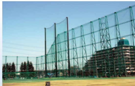
既設ネットの部分的な高上げ増設
