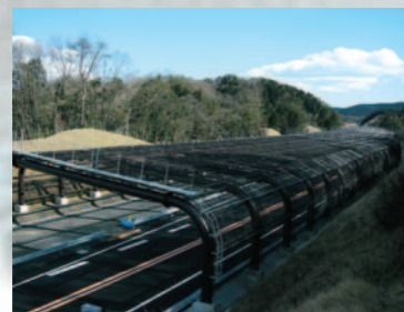
鋼管を用いた門型シェルター
