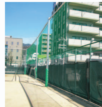
テニスコートのボール飛び出し防止の高上げ例
