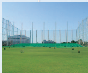
正面部ネットの高上げ
