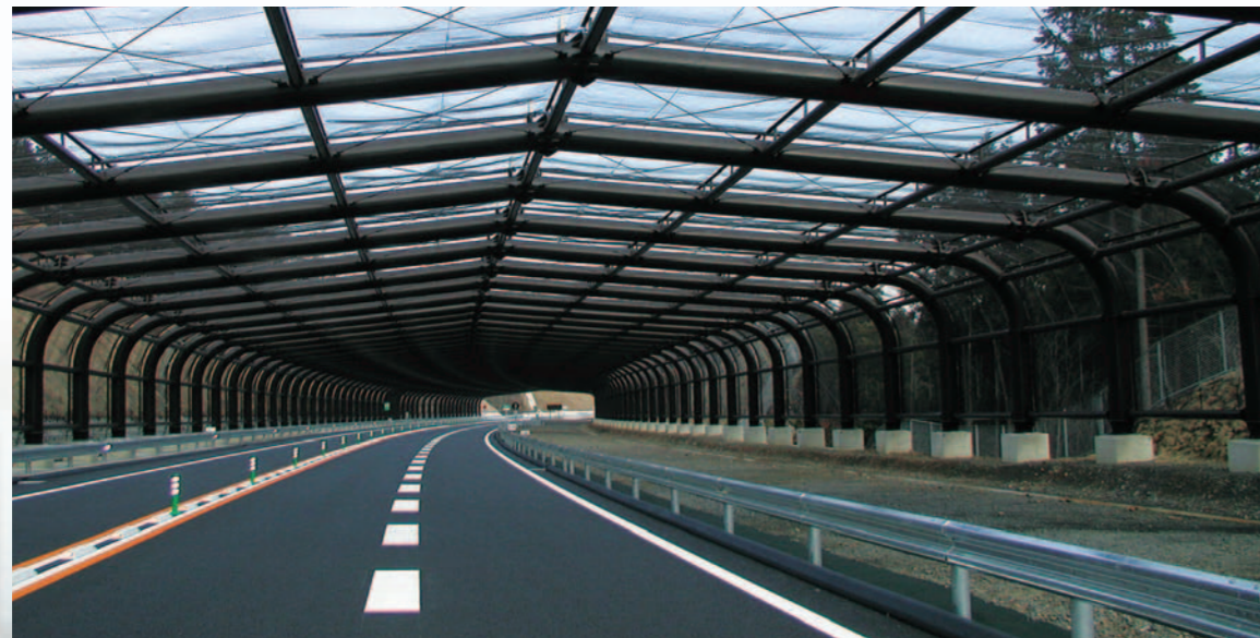
ゴルフ場脇の高速道路上空に設置された門型シェルター
