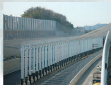
ポールと天井ネットによる防護例
