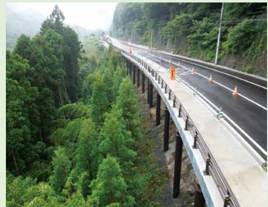
完成写真(拡幅タイプ)
