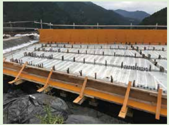
地覆木製型枠
