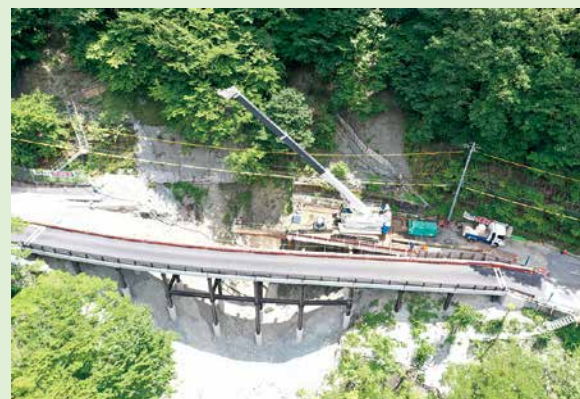
③ メタルロード側に通行路線を切り回し仮設栈橋を撤去
