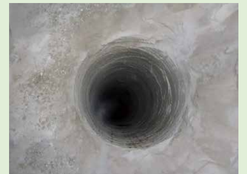
ダウンザホールハンマにて削孔した孔
