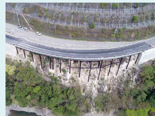
熊本県 国道445号 九折瀬
