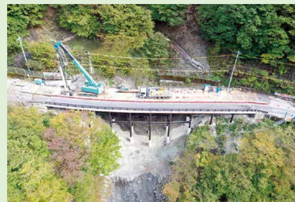
④ 山側1車線のメタルロードを構築し、構築済みのメタルロードと接続
