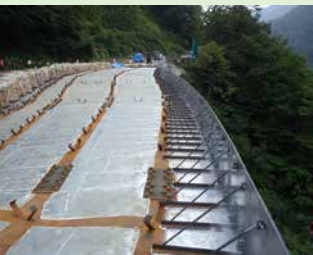
地覆鋼製型枠
