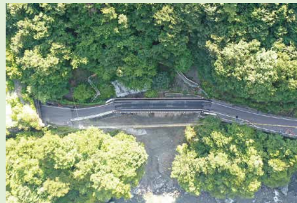
① 仮設栈橋により片側交互通行を確保
