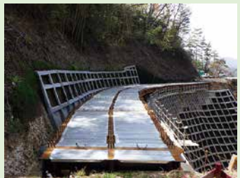
鋼製埋め込み型枠(底面部)
