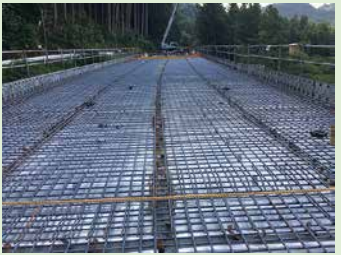
鉄筋工(床版配筋)
