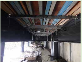
木製型枠(底面部)
