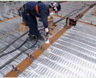
現場スタッド溶接
