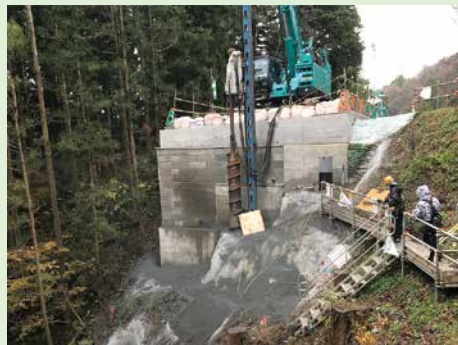
メタルロード取合擁壁
