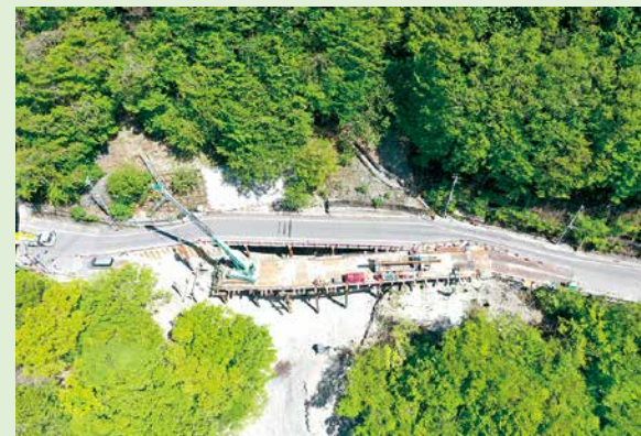
② メタルロードで本設道路1車線分を構築
