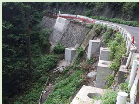
台座コンクリート(※)
