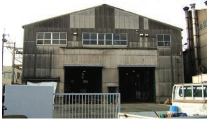
ブラザー第2工場 外壁リフォーム工事
