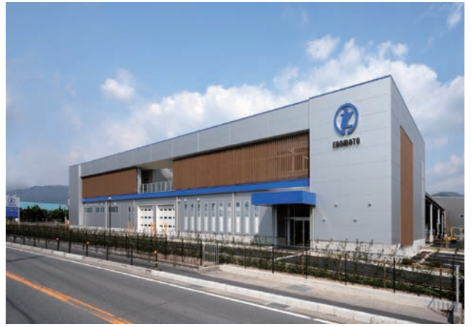
(株)エノモト新社屋（滋賀県）
