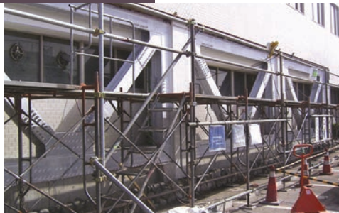
日本鋼管病院外来棟 耐震補強工事
