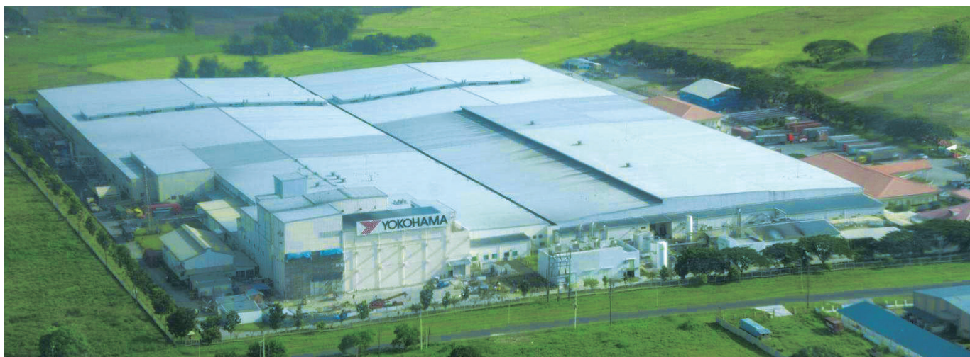
横浜ゴム殿 タイヤ工場建設(フィリピン)
