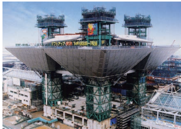
重量施設のジャッキアップ
