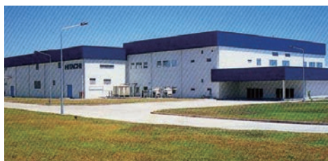
日立グローバルストレージ殿 HDD工場建設(フィリピン)
