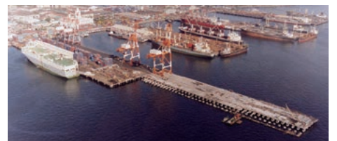
マニラ南港改修 / 拡張 (フィリピン)
