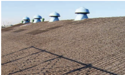
工場屋根 リフォーム工事
