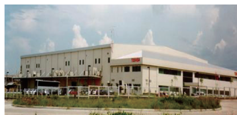
東芝殿 HDD工場建設(フィリピン)
