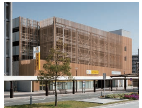
赤間駅北口立体駐車場（福岡県）
