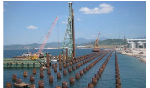
スービックコンテナターミナルの杭打ち (フィリピン)
