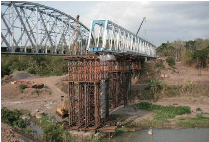
ジャワ南線複線化工事 (インドネシア)
