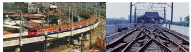
ジャボタベック中央線高架化工事 (インドネシア)
