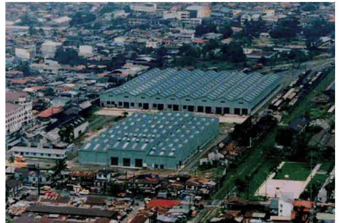
フィリピン国鉄車両基地改修工事 (フィリピン)
