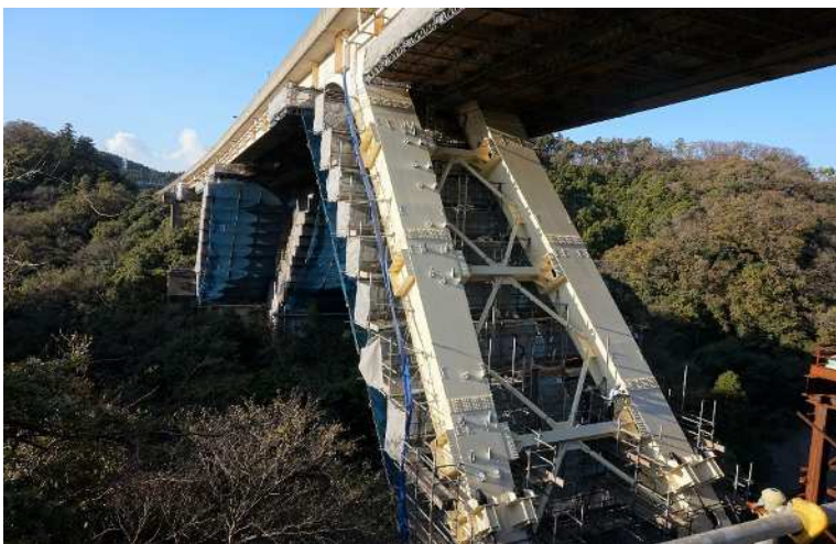
橋梁全景(二重鋼管ダンパー設置)
