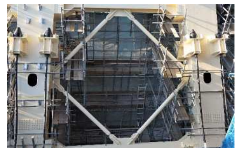
二重鋼管ダンパー設置状況
