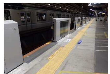
ホームドア設置完了
