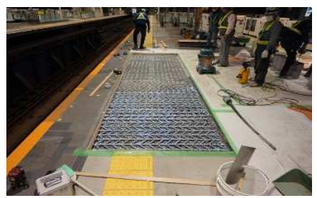
コンクリート打設前 (プライマー塗布)
