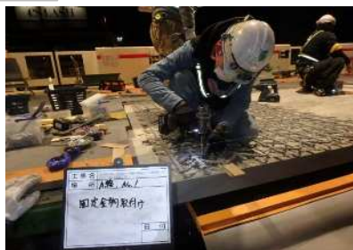
グリッドメタルの設置作業
