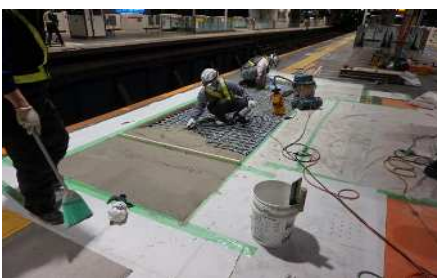
モルタル打設状況
