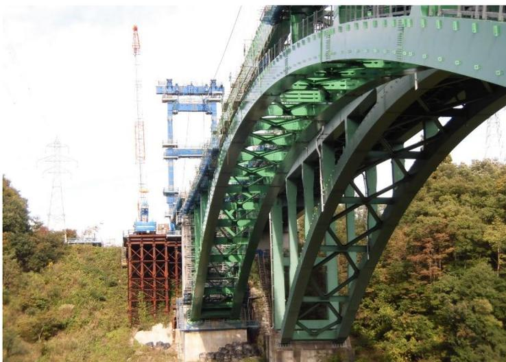
二重鋼管ダンパー設置状況写真
