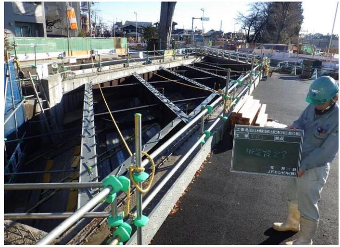
桁架設完了
