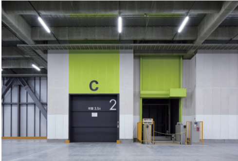
上／倉庫内部 下2点／荷物用EVと垂直搬送機 エリアごとに色を変えている
