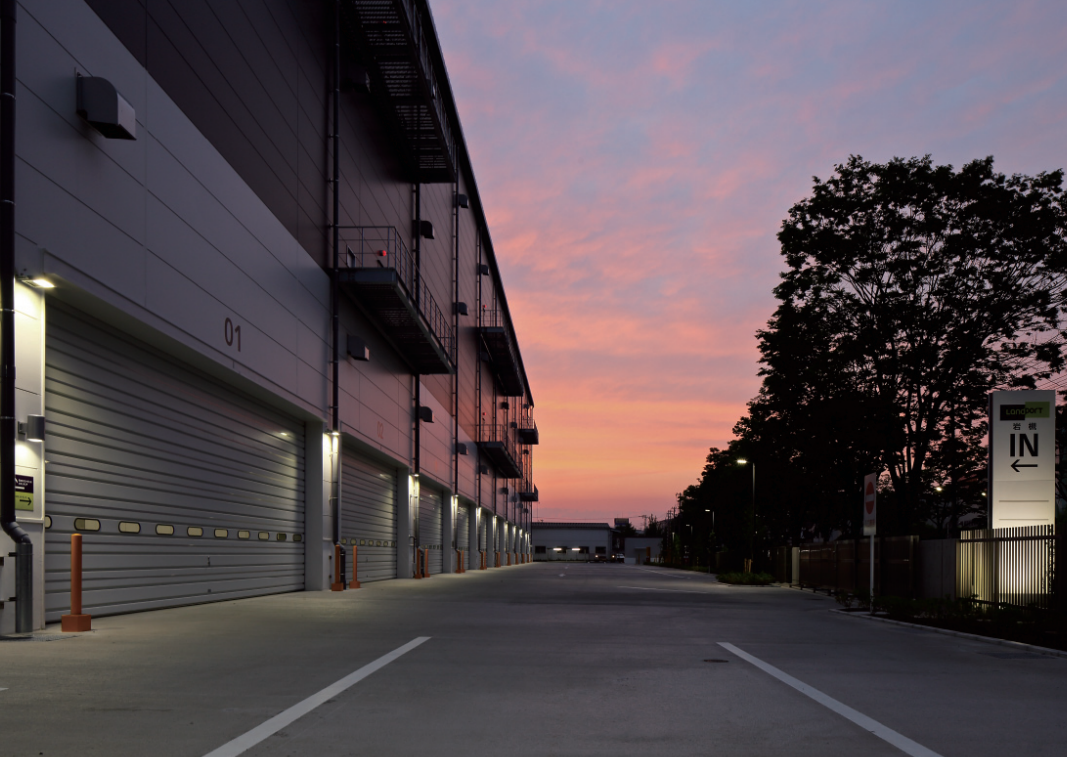
上／北東側外観 下／構内通路(トラック動線)
