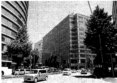
二重鋼管座屈補剛ブレースが採用されたJRP博多ビル
