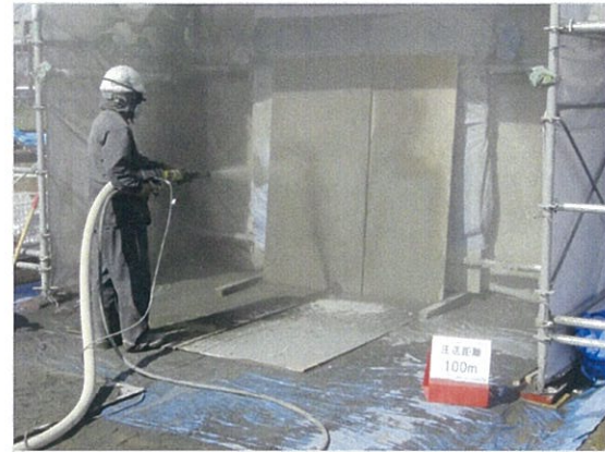
壁面での厚付施工状況
