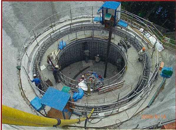
立坑覆工コンクリート 作業の状況
