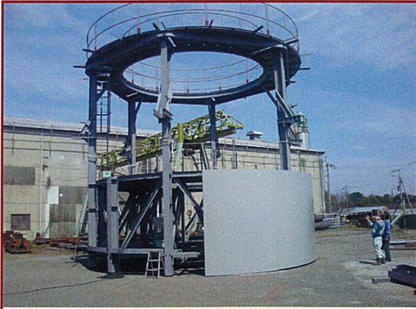
立坑ジャンプフォーム装置 (半面に型枠を取付けた状況)
