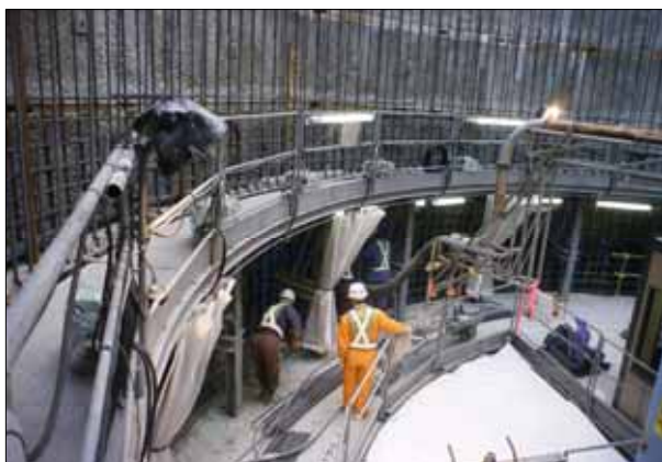
スライド型枠内へのコンクリート充填
