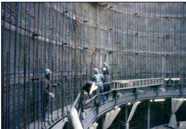
上部デッキでの鉄筋組立状況
