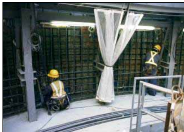
中間デッキでの鉄筋組立
