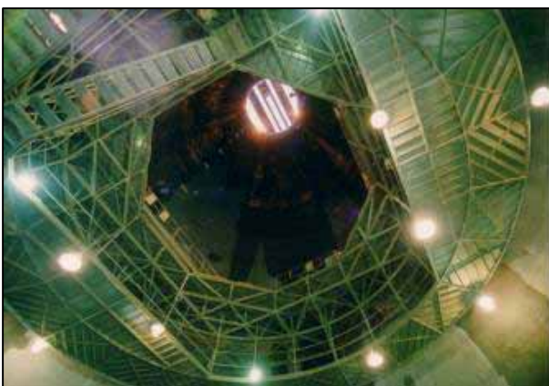
深さ110mの立坑下部からみた作業床
