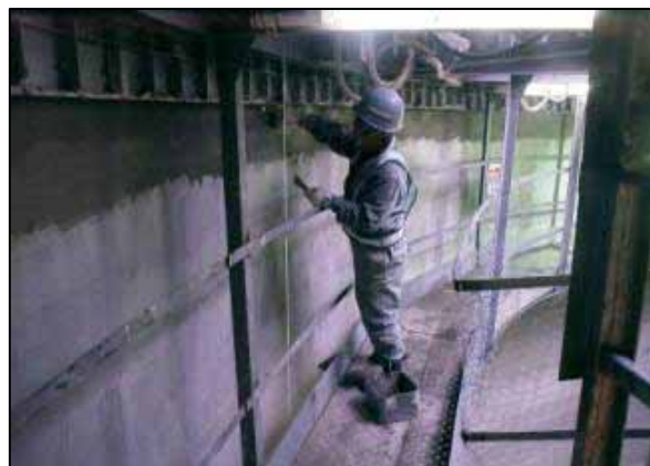
スライドアップ後のコンクリート仕上
