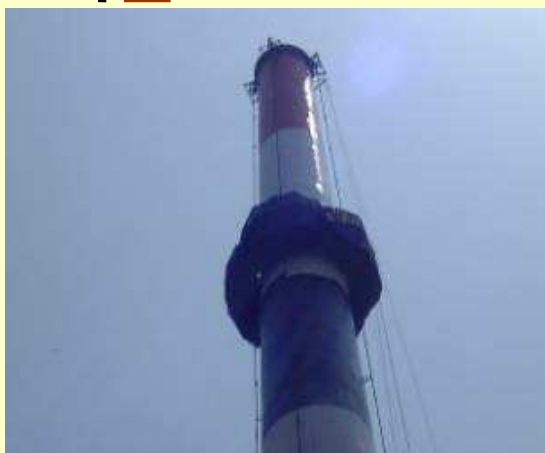
作業床を降下させながら塗装塗替を実施
