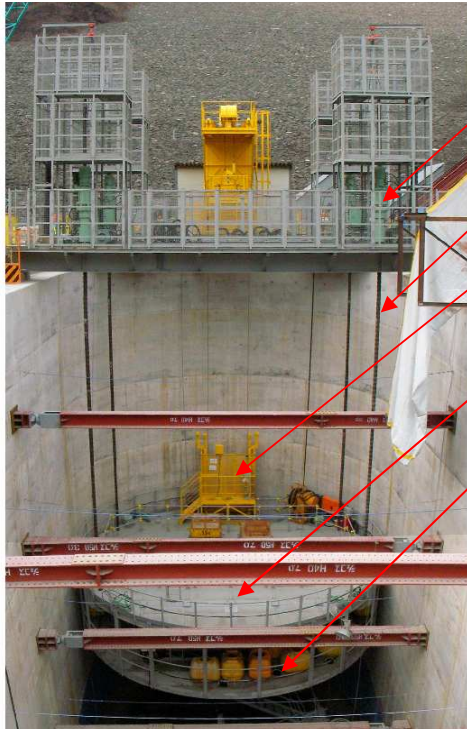
重機等の重量物を搭載した大型の作業構台の昇降に適用できます
