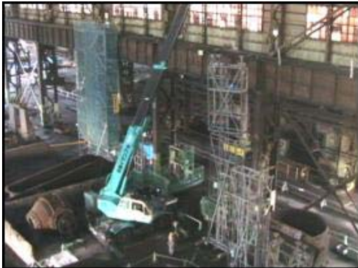
作業ユニットの設置
