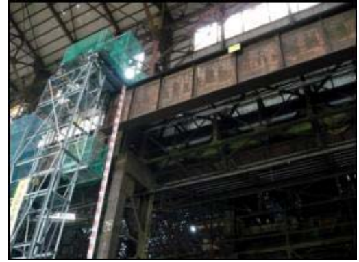
既設ガーダー吊上げ横移動
