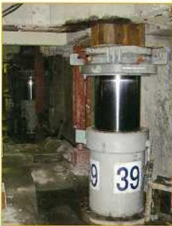
800トンジャッキ44台がビルの柱を支えて伸縮。
