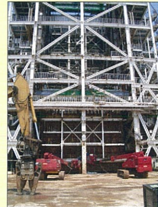
下部での解体状況
