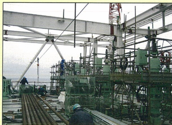
屋上に設置したアップダウンジャッキ
