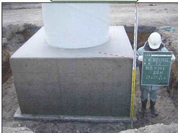
根巻コンクリート完了
