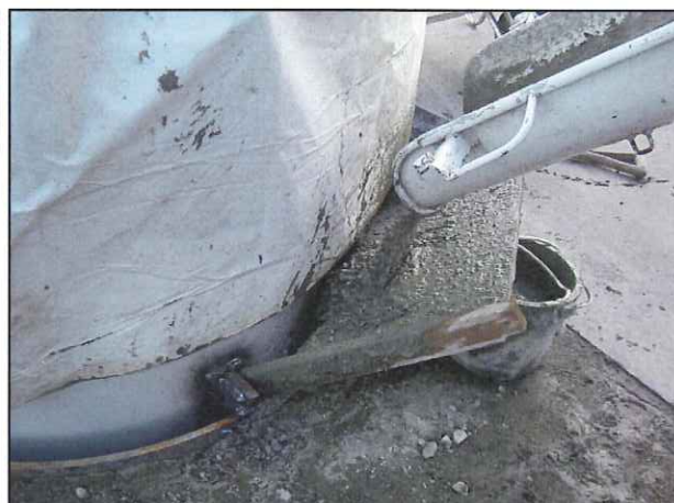
周面コンクリート充填
