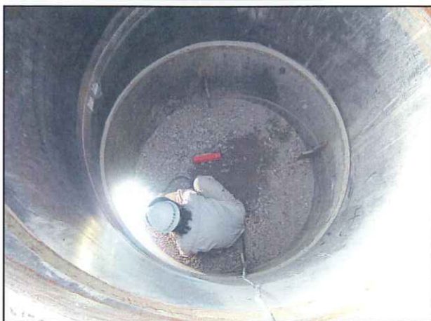
鋼管杭内の支持リブ取付け
