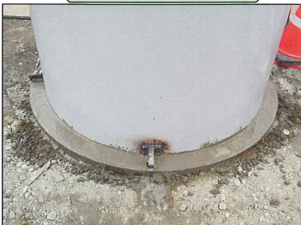
周面コンクリート打設後
