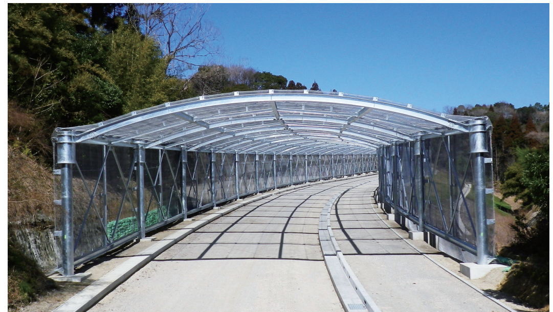
県道宮崎高鍋線 那珂工区 (宮崎県宮崎市)
