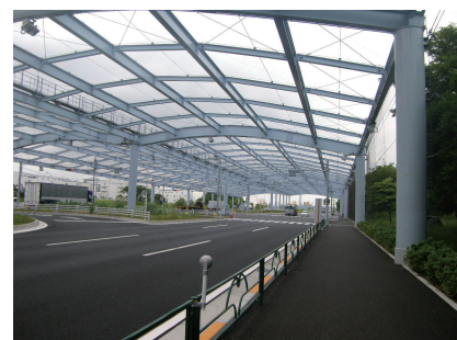
東京港臨海道路 (東京都江東区)
