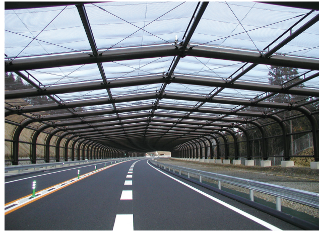
東海環状自動車道 (岐阜県土岐市)
