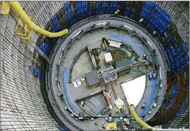
発電所導水トンネルシールドマシン発進立坑 (覆工コンクリート用スリップフォーム)
